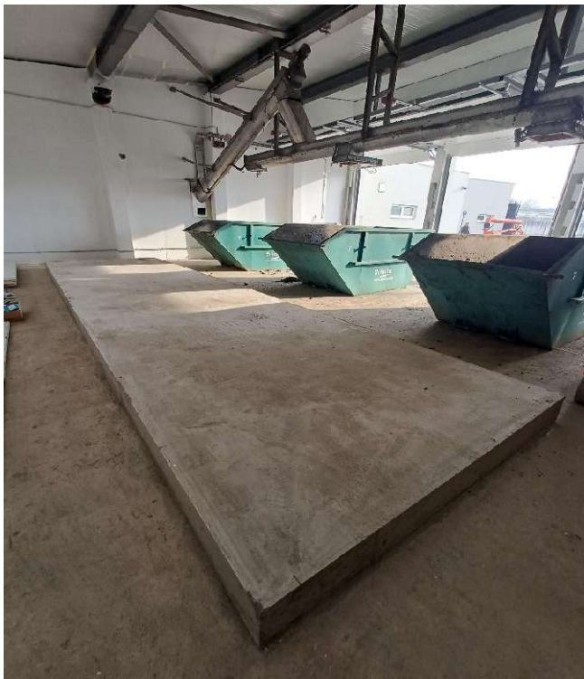
Slika 3. Izgradnja postrojenja za sušenje otpadnog mulja
