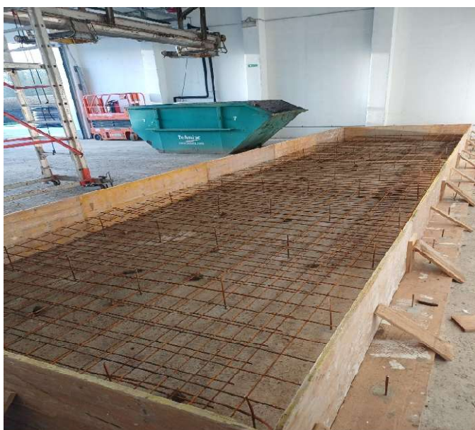
Slika 2. Izgradnja postrojenja za sušenje otpadnog mulja
